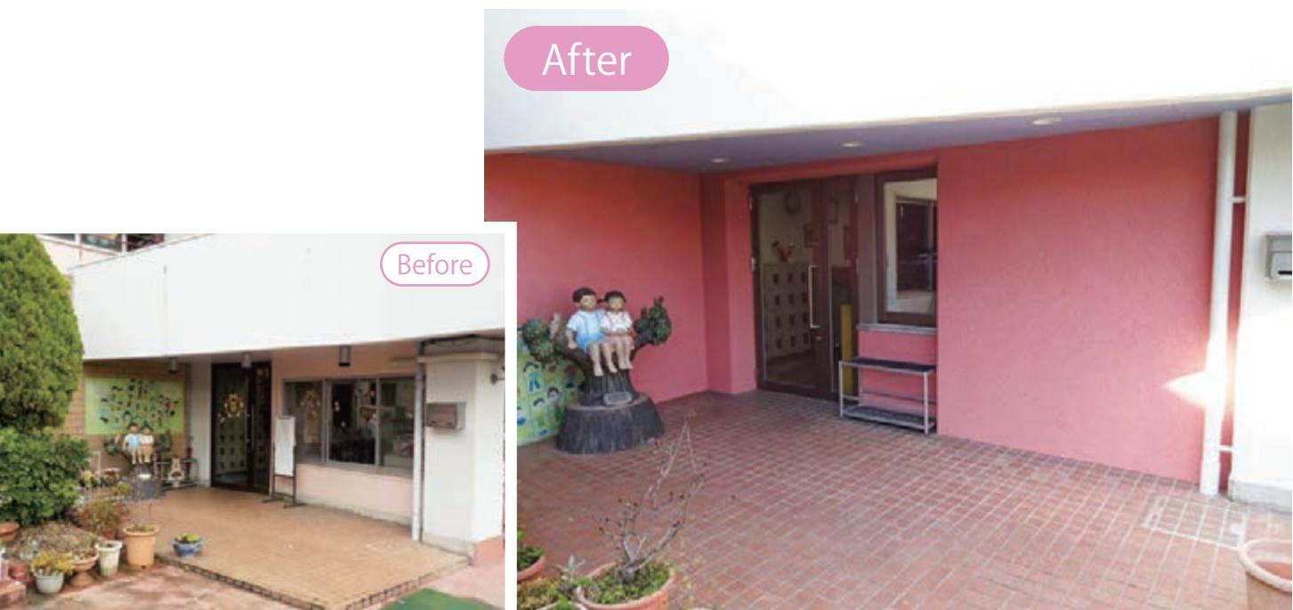
耐震補強のため鉄骨ブレースを4ヶ所設置。玄関は機能性と景観を考慮して耐震壁としました。
