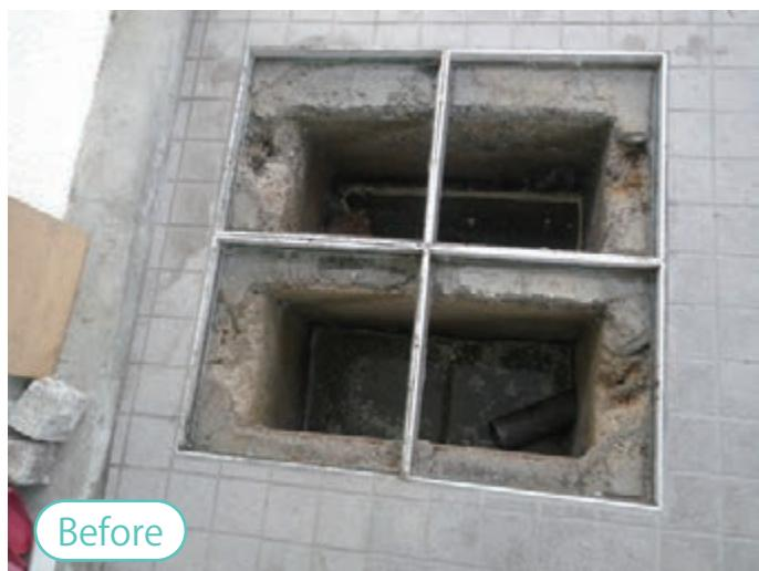
老朽化したコンクリート製のグリーストラップを FRP 製に改修し「オゾン改善システム」も導入し、衛生面、清掃面の改善を行いました。
