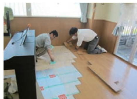
短期間で施工するために、既存床に床暖を設置する事で、段差を考慮し施工しました。
