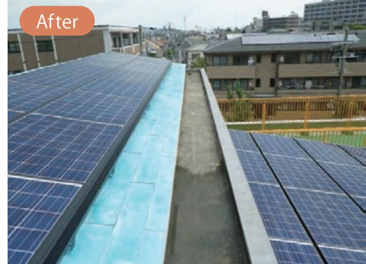
屋上のメンテナンススペースと屋根の一部に太陽光パネル 49 枚配置し、10kW を発電します。
