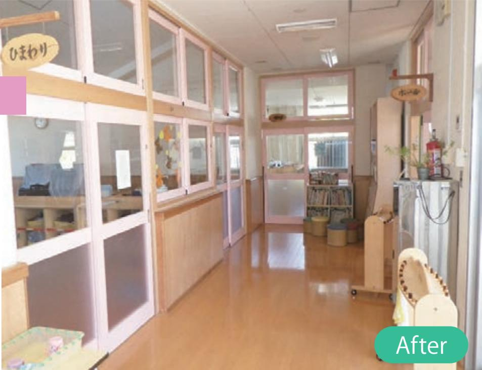
老朽化と安全面を考慮し、出入口の建具をアルミ製から木製に変更し、指詰め防止ゴムや上部に両面鎌錠を取り付けました。
