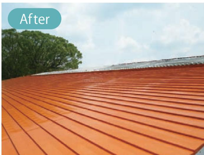
10年経ち、色あせ・劣化も目立つため、現状のガルバニウム鋼板の屋根に、屋根用遮熱塗料にて塗替しました。遮熱効果が期待されます。
